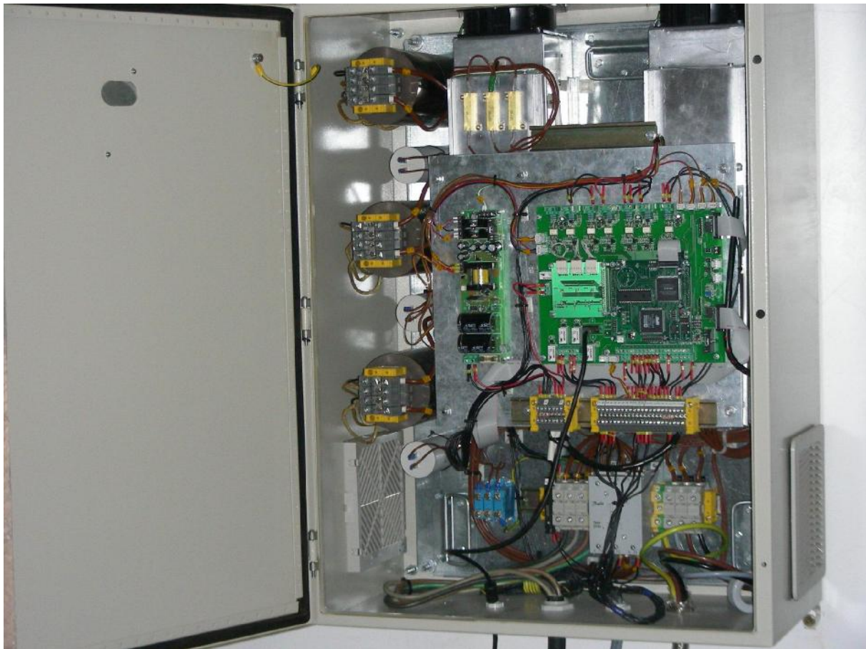
Fot. 4. Falownik MMB z wyposażeniem dodatkowym. Z lewej strony wysokoczęstotliwościowe dławiki filtra sieciowego. W centralnej części płyta sterowania elektronicznego falownikiem
